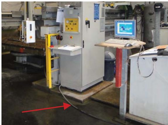
Bild 10: Kabelverlegung an der Maschine
