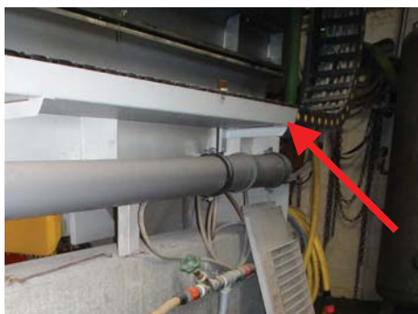
Bild 3: Quetschstelle an Energiekette
